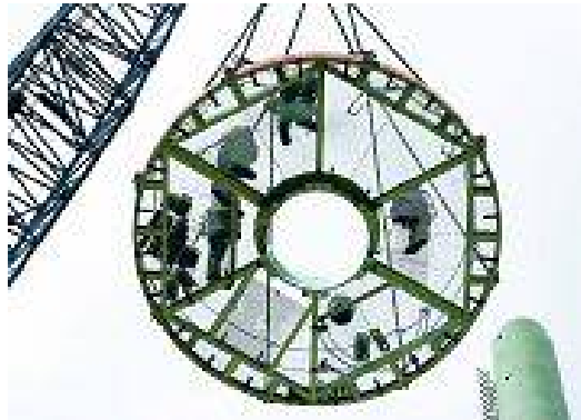
Abbildung 6.1: Montage des UMTS-Sendemastes in Schopisdorf
