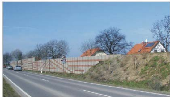
Burgliebenau, Schallschutzwand WG Mühlbreite
