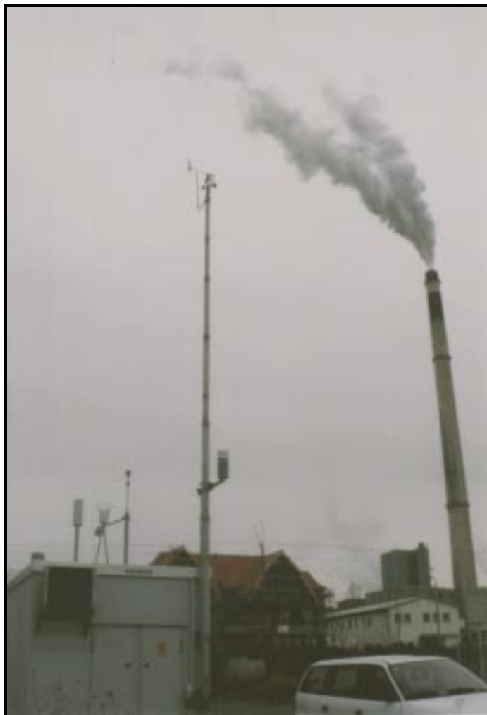
Abb. 8: LÜSA-Station Amsdorf; Blickrichtung SSW
